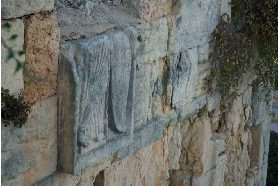
FIGURA 3. Detall del relleu de Minerva en la torre homònima, primera fase constructiva.
